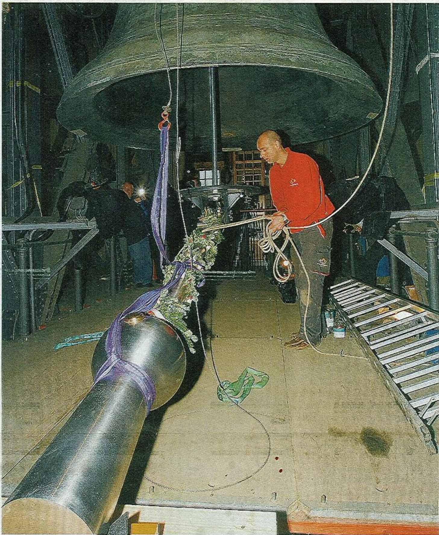
Der neue Klöppel für den „Decken Pitter“ wird montiert.
