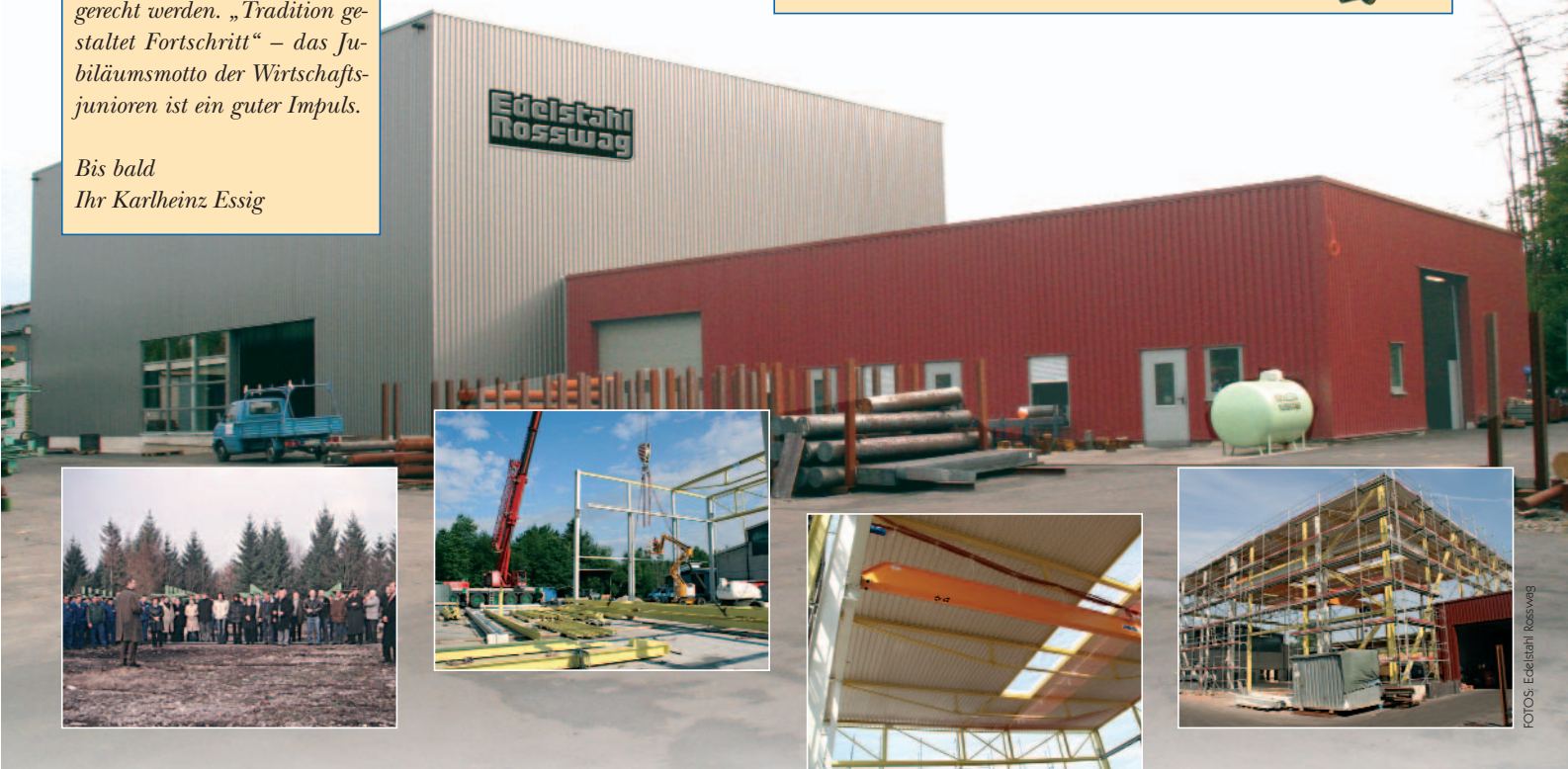
Vom ersten Spatenstich bis zur Fertigstellung: der neue Erweiterungsbau bei Edelstahl Rosswag
