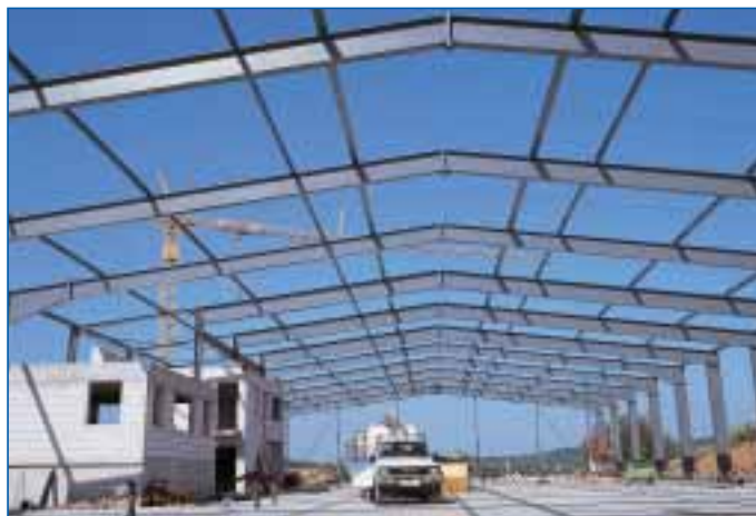
Material passend zur Unternehmensbranche: Das nackte Stahlträger-Skelett läßt die Ausmaße des Bauwerks erkennen. Foto: Dürbach
